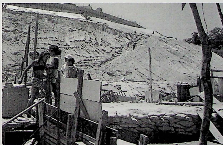
Foto 5 - 5a (2008), 5b e 5c(2010) – Jardim Santa Rita – Osasco. Talude antes do deslizamento de terra e depois. Detalhe para locais reconstruindo as moradias e ao fundo empresa de sondagem executando ensaios SPT para estudos de contenção do talude. Fonte: Google Earth (5a)
